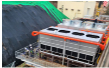
2023.1 고효율 Eva-Con 설치 [투자효과] 고효율 Eva-Con 설치로 에너지 효율 증대
