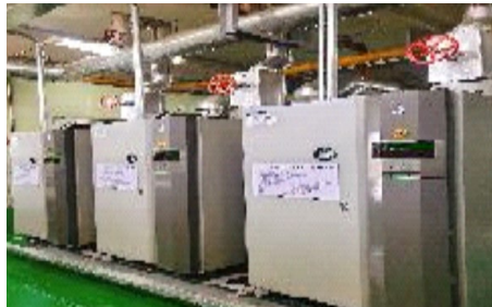
2023.3 고효율 관료실 보일러 도입 [투자효과] 기존 수관식에서 관류식 보일러로 교체함으로써 에너지 절감 / 온실가스 감축
