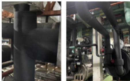
2023.1 브라인 배관 도입 [투자효과] 브라인배관 방냉 손실 개선으로 에너지 절감 / 온실가스 감축
